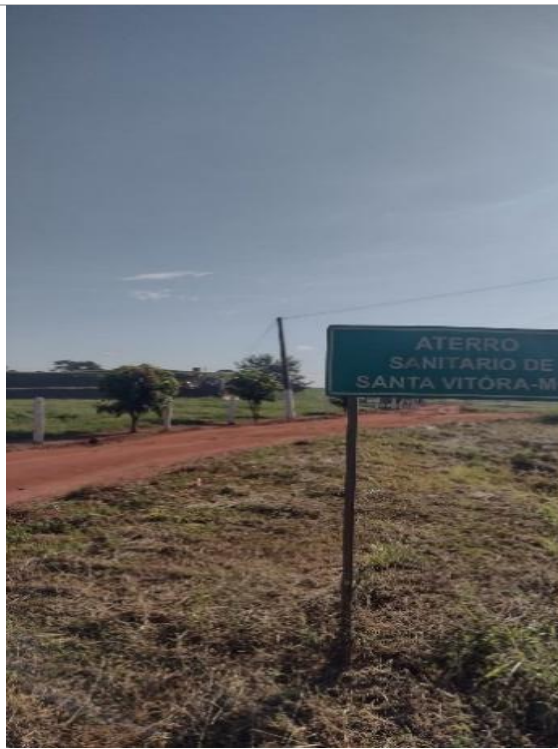
Figura 166: Guarita e placa de identificação do Aterro Sanitário de Santa Vitória – MG
