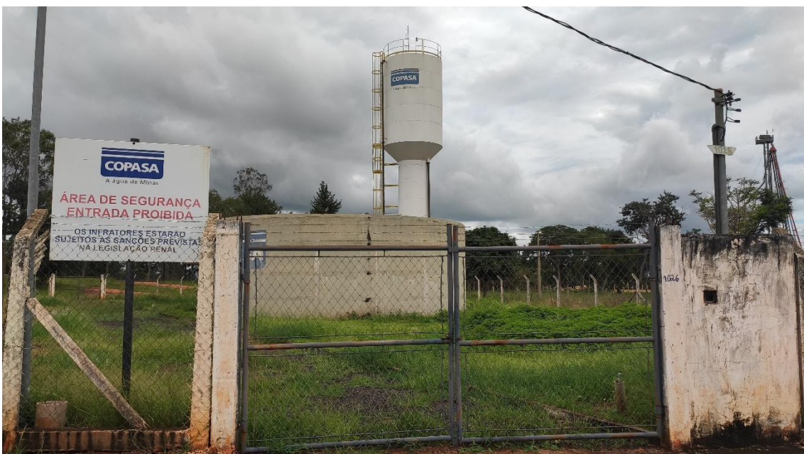
Figura 93: Reservatórios apoiado e elevado de água tratada
