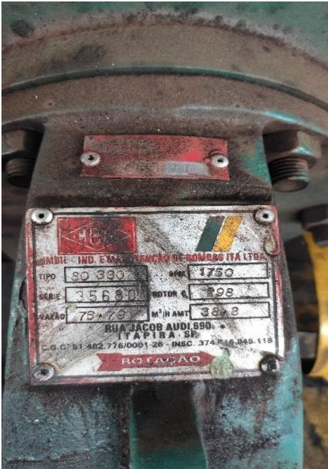
Figura 91: Características do conjunto motobomba à esquerda do conjunto mais à direita
