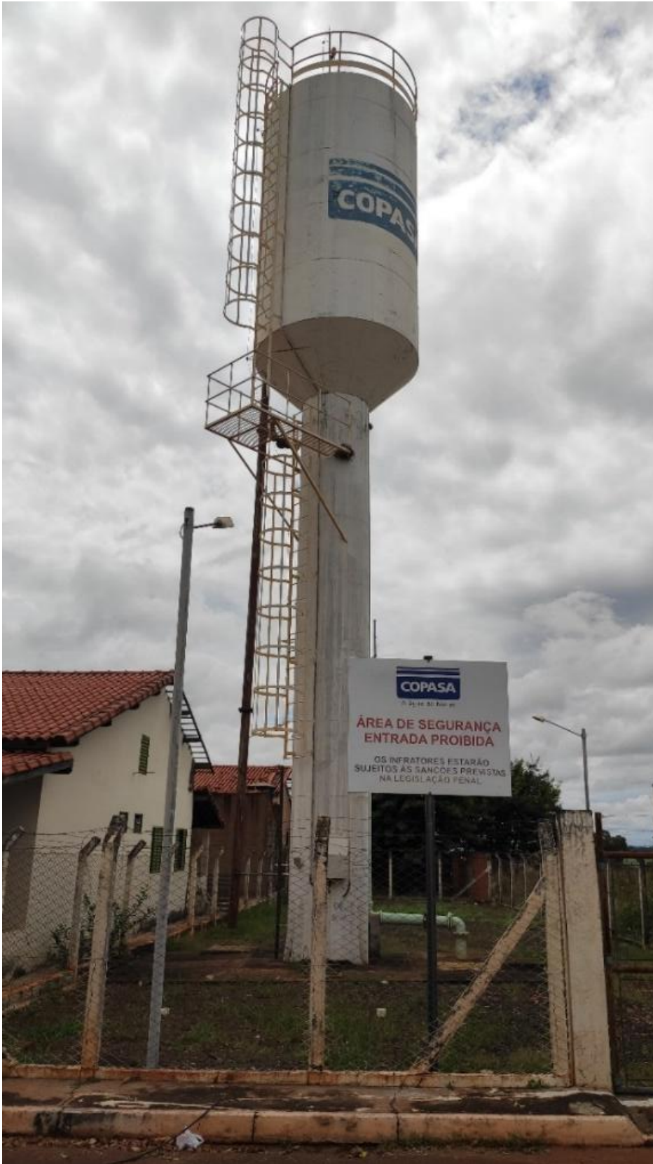
Figura 94: Reservatório elevado de água tratada
