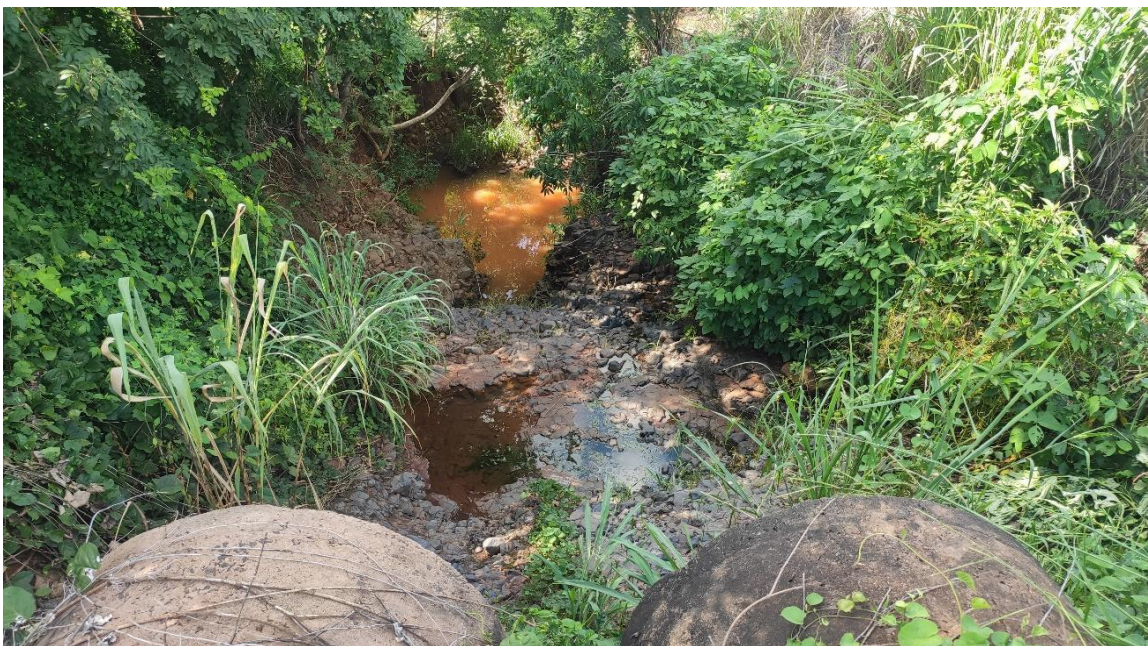
Figura 129: Dissipador/ponto de lançamento das galerias de águas pluviais finais de Chaveslândia
