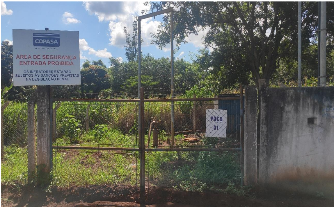
Figura 104: Poço tubular profundo 01
