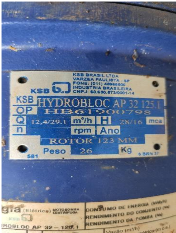
Figura 99: Características do conjunto motobomba 02
