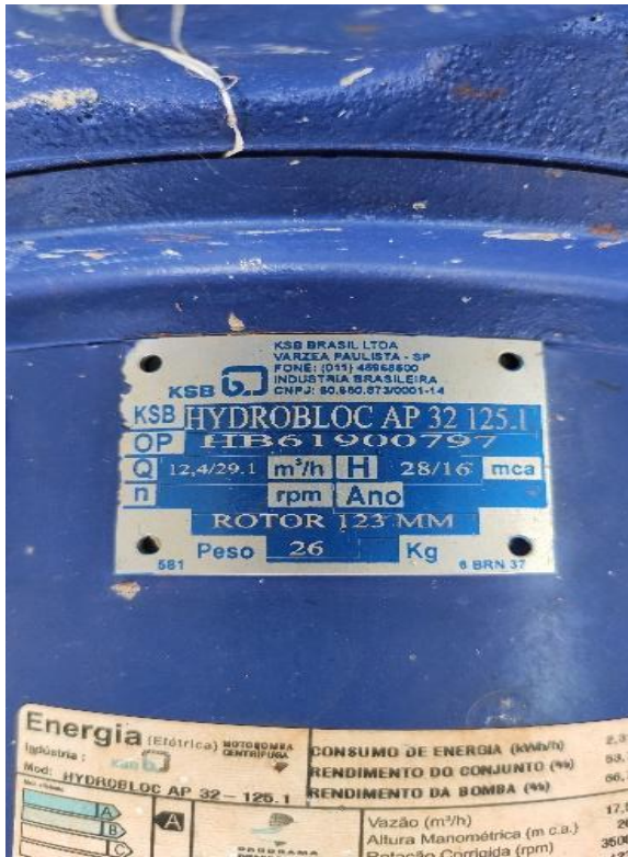
Figura 98: Características do conjunto motobomba 01
