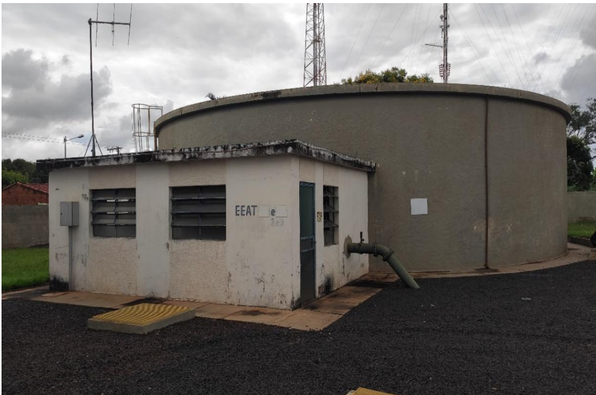
Figura 85: Reservatório apoiado de água e estação elevatória de água tratada
