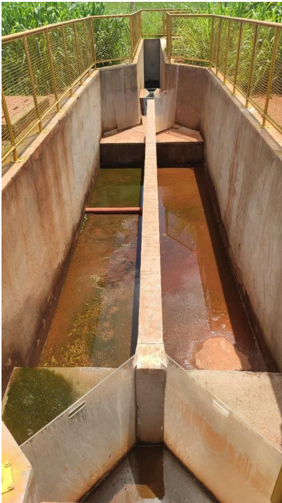
Figura 116: Caixas de areia e calha Parshall
