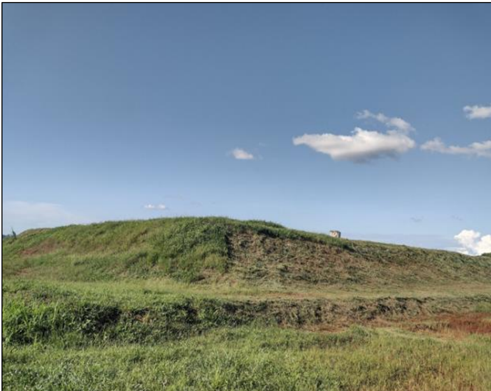
Figura 172: Valas sanitárias encerradas com plantio de gramíneas e cerca viva do Aterro Sanitário de Santa Vitória – MG
