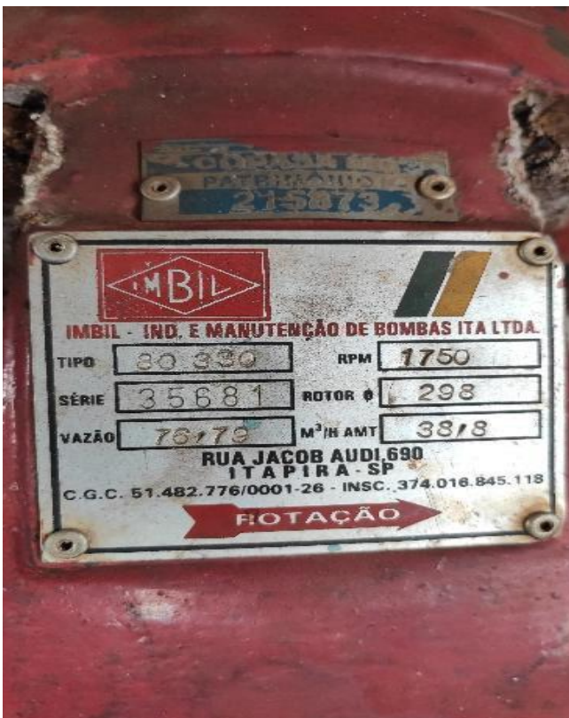
Figura 90: Características do conjunto motobomba mais à direita
