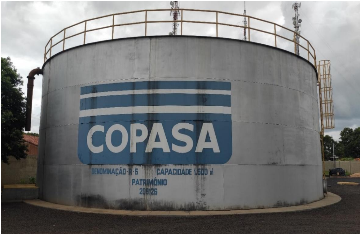
Figura 84: Reservatório apoiado de água tratada
