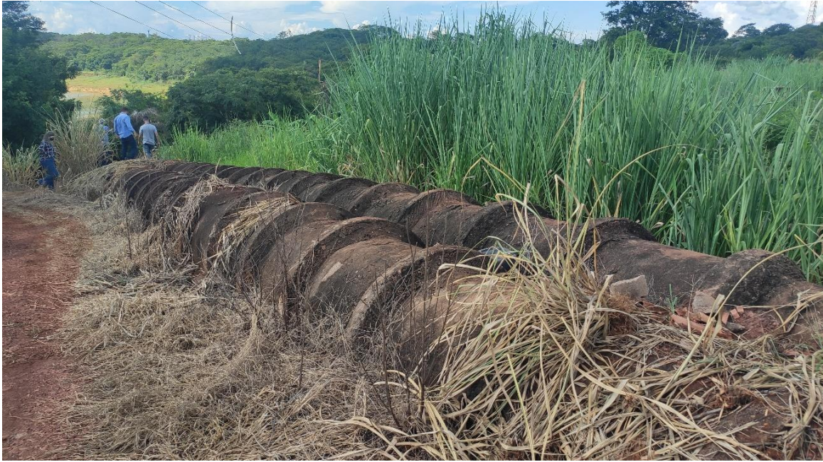
Figura 129: Dissipador/ponto de lançamento das galerias de águas pluviais finais de Chaveslândia
