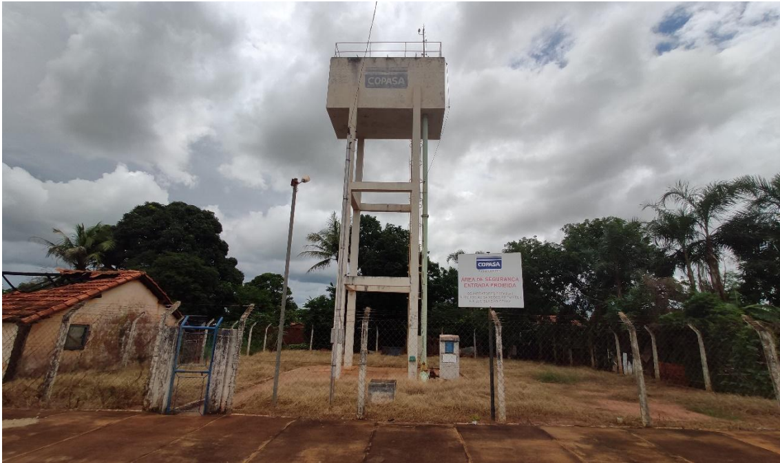
Figura 100: Reservatório elevado de água tratada
