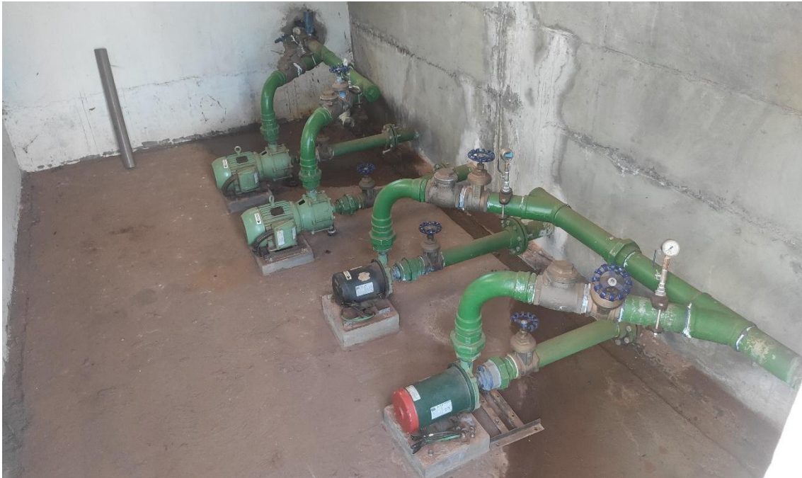
Figura 107: Estações elevatórias de água tratada agrupadas
