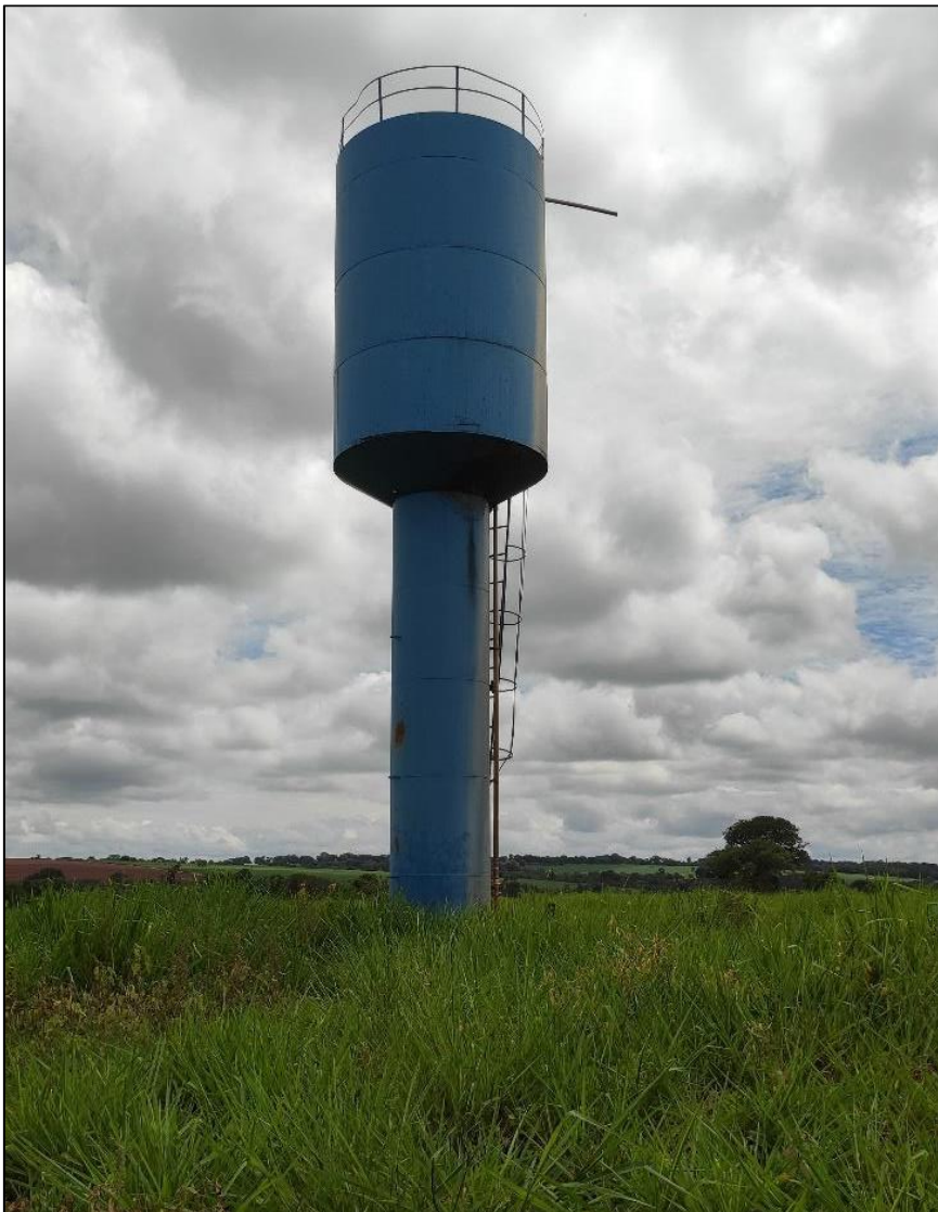
Figura 114: Reservatório elevado de água
