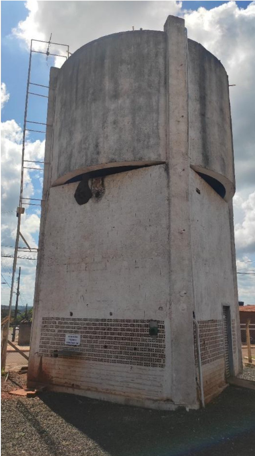
Figura 111: Reservatório elevado de água tratada
