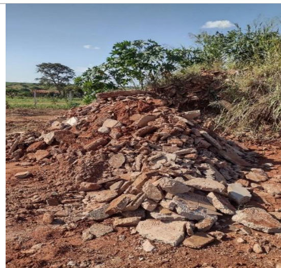
Figura 157: Disposição de resíduos de construção civil sem triagem adequada no Parque Industrial da Prefeitura de Santa Vitória – MG
