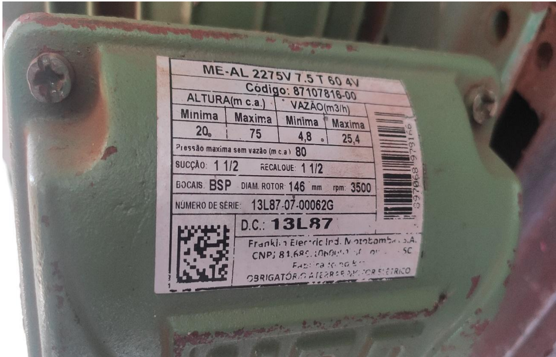
Figura 109: Características do conjunto motobomba à direita do conjunto mais à esquerda
