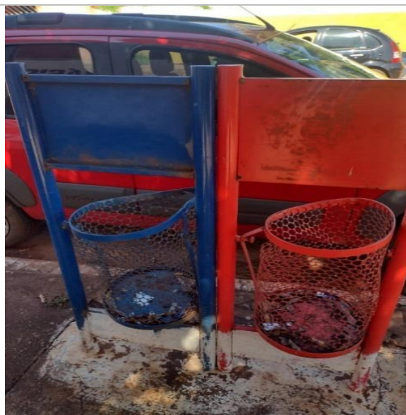
Figura 138: Lixeiras instaladas no município de Santa Vitória – MG para acondicionamento de resíduos
