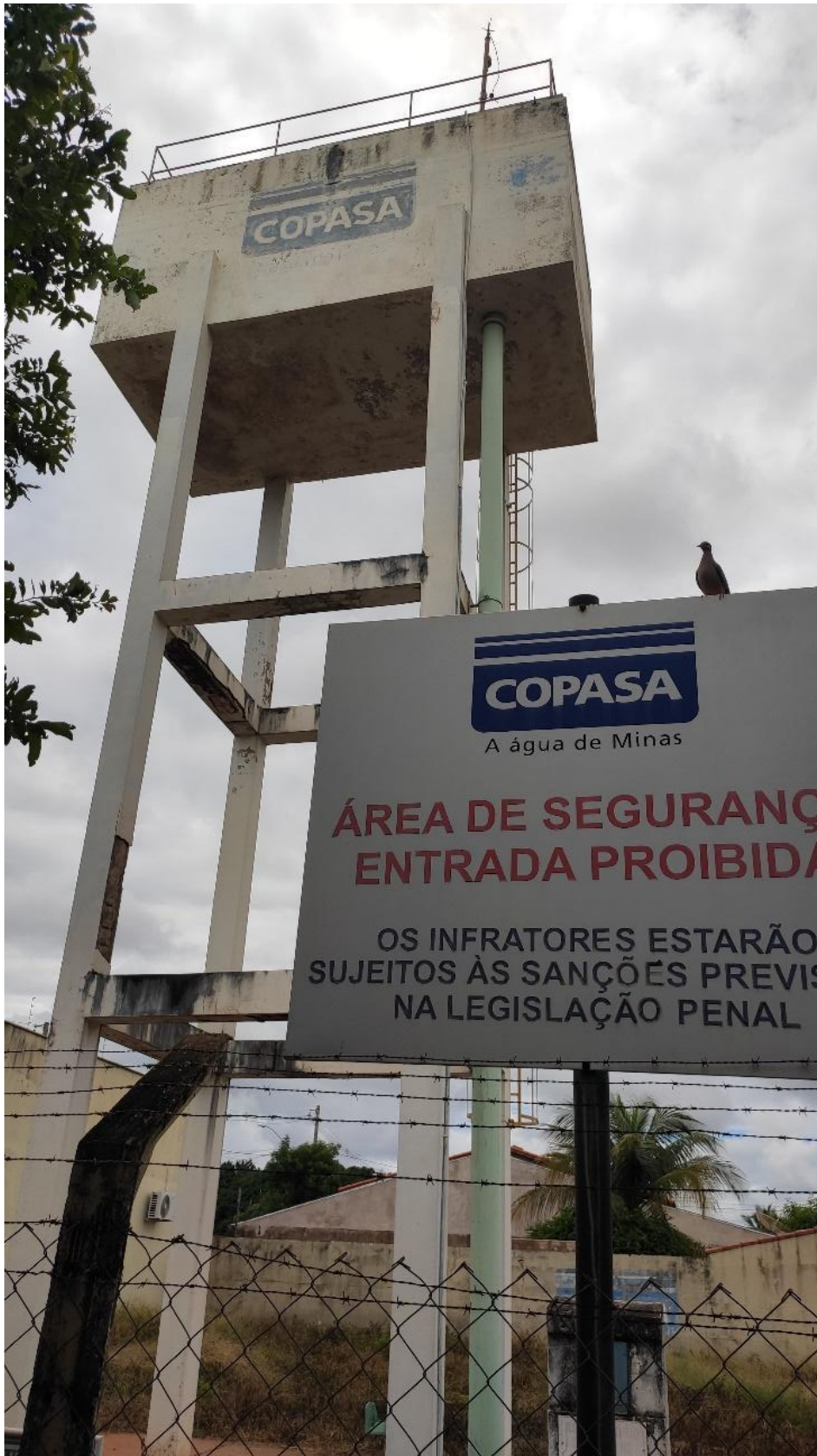
Figura 95: Reservatório elevado de água tratada
