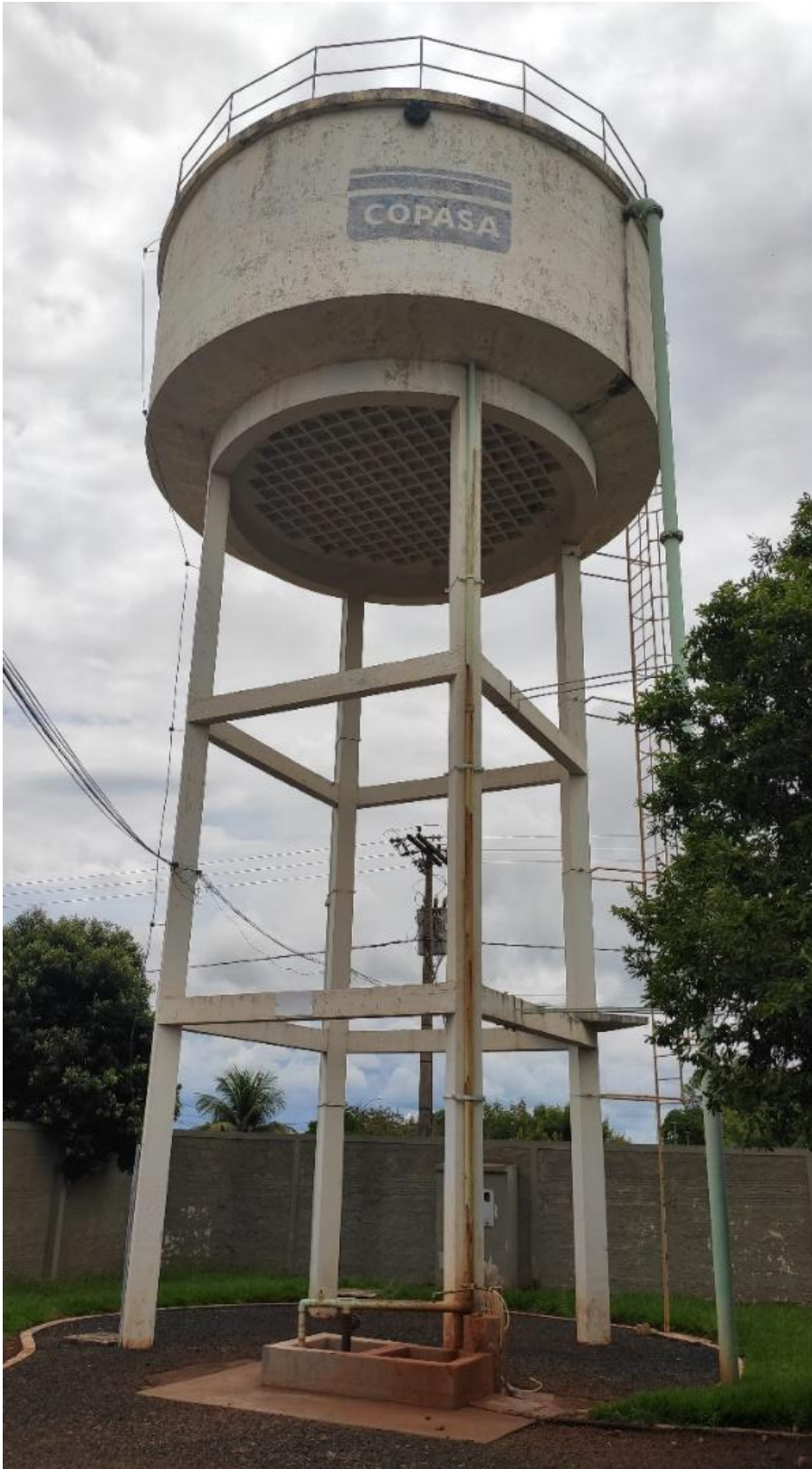
Figura 86: Reservatório elevado de água tratada
