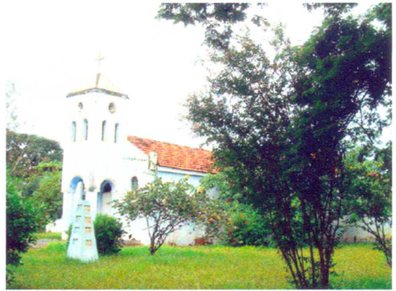
Foto 02 – Vista lateral da Capela Nossa Senhora Aparecida, inserida na Praça Aparício de Almeida. Município de Santa Vitória – distrito de Perdilândia Data: 12/02/2009
